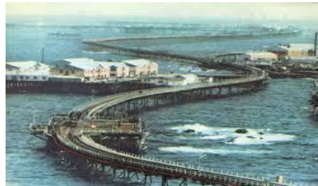
Estekada Эстекада Scaffold bridge,rack
